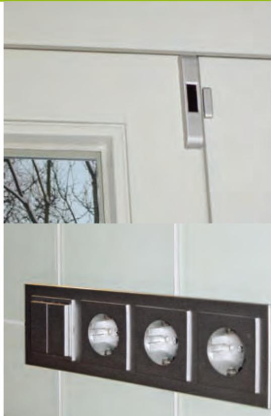
wird, wird automatisch die Raumtemperatur herunterdreht, um Energie zu sparen. Beim Schließen des Fensters wird sie wieder automatisch erhöht. Alle Komponenten wurden an das I/O-Automationsystems von WAGO angebunden. Dadurch können Heizung, Rollläden und Licht zentral gesteuert werden.
