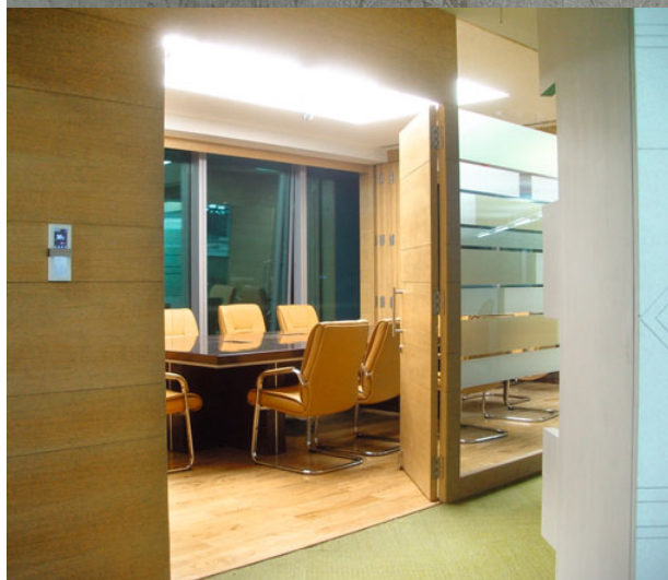
Die Funkfühler SR04 mit Solarzelle (Bild oben) erfassen die Temperatur in den Büros und verarbeiten Sollwerte.
