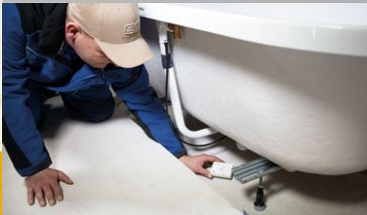
Unten rechts: Platzieren des Leckage-Sensors WaterSensor eco zur Überwachung des Bereichs unterhalb der Badewanne. Der Sensor kommt ohne Energie aus und ist somit zeitlich unbegrenzt einsatzfähig.
