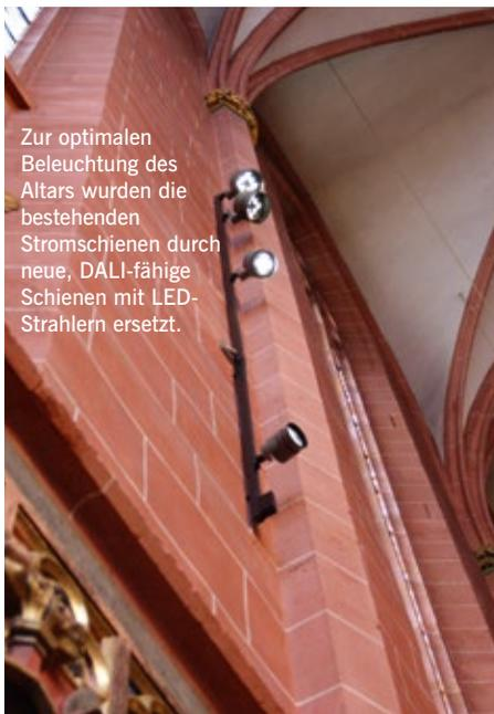
Zur optimalen Beleuchtung des Altars wurden die bestehenden Stromschienen durch neue, DALI-fähige Schienen mit LED-Strahlern ersetzt.
