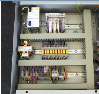
Die standardisierten Systemverteiler vereinfachen die Inbetriebnahme vor Ort
