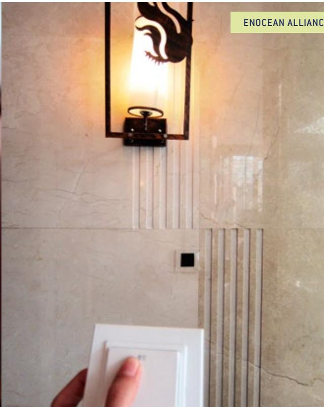
Mit ihren batterielosen Funkschaltern und Präsenzmeldern sorgt die Lösung für ein Höchstmaß an Komfort. So ist es beispielsweise möglich, die Beleuchtung im ganzen Haus mit nur einem Schalter zentral zu bedienen. Ebenso gut kann aber auch eine bestimmte Lampe von mehreren Schaltern oder Präsenzmeldern gesteuert werden.
