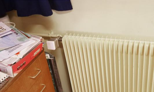
Unauffällig integriert: Wartungsfreie Sensoren und Aktoren lassen sich einfach nachrüsten und flexibel positionieren.
