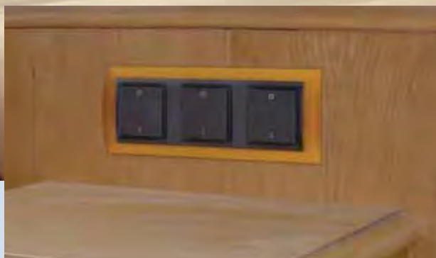
Beleuchtungssteuerung mittels batterieloser Funkschalter in den komfortabel renovierten Hotelzimmern.
