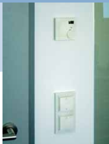
Bild unten: Raumfühler und Taster mit EnOcean-Technologie
