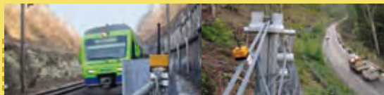
Impact Sentinel ist ein funkgestütztes System zur Überwachung von Steinschlagereignissen bei den Schweizerischen Bundesbahnen (SBB).
